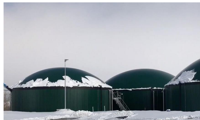
12 @SIEL42 · 25 août 2018 Intérieur de l'une des 3 cuves du futur méthaniseur agricole #Méthamoly à St Denis sur se #biogaz
