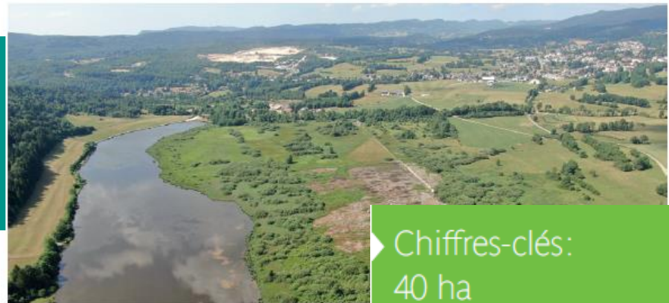
Vue aérienne des travaux de réouverture du marais de Vaux. ©CEN Rhône-Alpes
